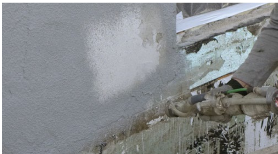
Materialauftrag im Spritzverfahren auf eine Altbeschichtung
