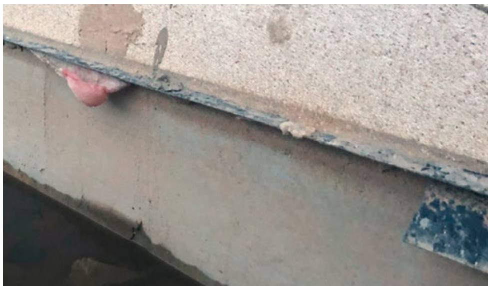
Querschnittsabdichtung mit herkömmlicher Mauersperrbahn
